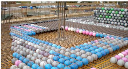
Abb. 204 | Gitterstäbe sichern die Kunststoffbehälter und sorgen für die nötige Stabilität.
