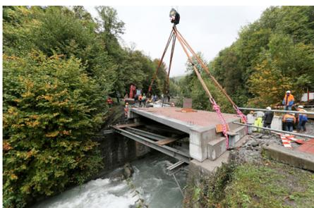
Abb. 205 | Die komplette Balsaholzbrücke wird in Bex (VD) aufgestellt.
