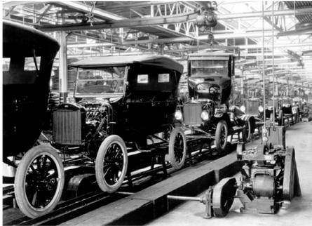
**Abb. 263 | Autos wurden in den Fordwerken bis 1913 handwerklich produziert. Ein Jahr später gruppierte man alle Maschinen in der Reihenfolge der Bearbeitungsschritte. Dies verkürzte den Weg auf ein Zehntel. Die Bearbeitungszeit in der Endmontage wurde von 750 auf 93 Minuten verkürzt. Das Fließband war nur eine Konsequenz dieser Arbeitsorganisation.**
