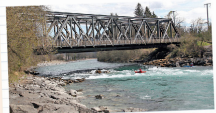
Abb. 2: Aare bei der Uttigerbrücke am 11. April 2021 mit Kanalisierung aus dem 19. Jahrhundert und Schwellen aus dem 20. Jahrhundert. (Foto: Probst)
